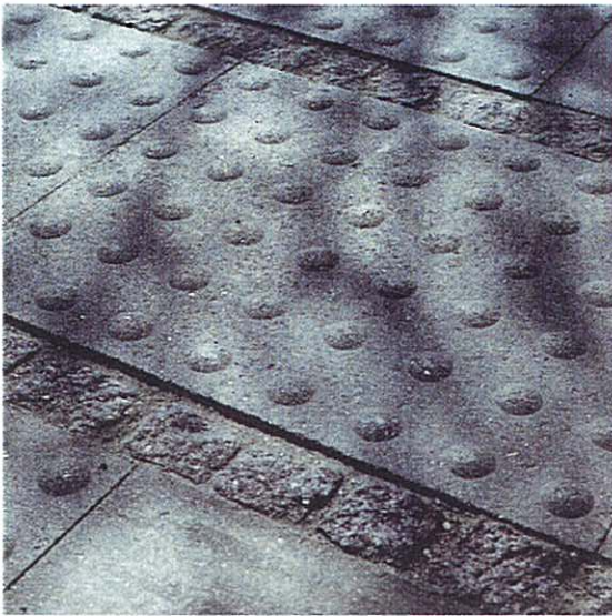
Eksempel på skift i belægning/ opmærksomhedsfelt
