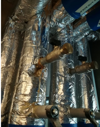
Tærring på brugsvandsinstallation i varmecentral
