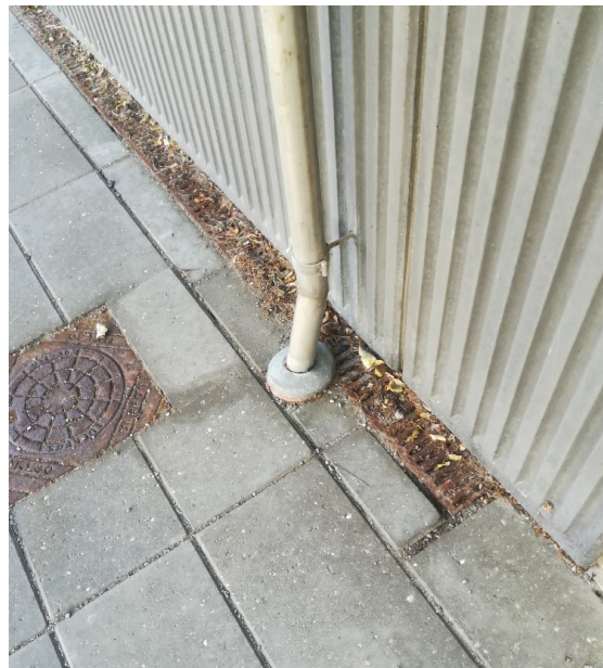
Rustent linieafløb og manglende oprensning
