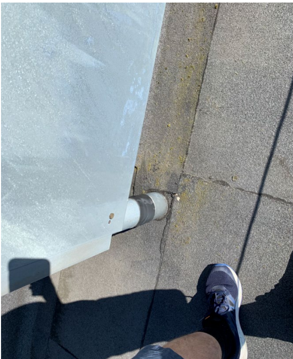
Manchetter og stålplader på inddækning omkring ventilationsanlæg
