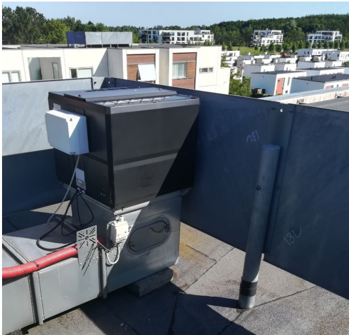
Udsugningsanlæg, tagventilator med påmonteret styring.
