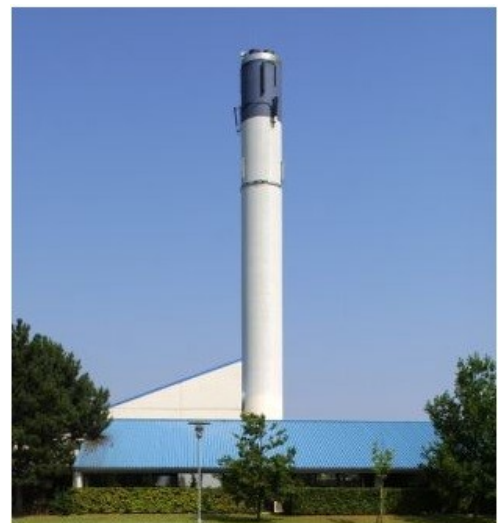
Farum Fjernvarme a.m.b.a. Stavnsholtvej 33, 3520 Farum
