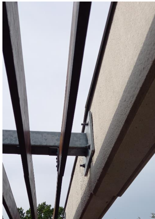
Figur 13: Løst betonelement - udhæng nr. 11.
