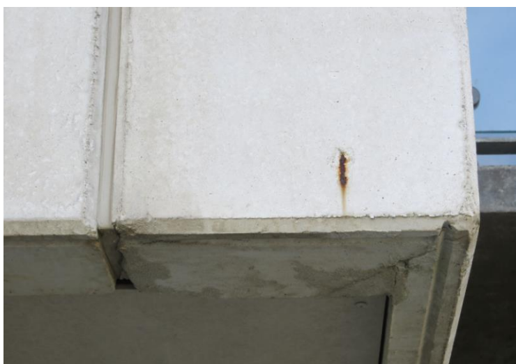
Figur 7: Typisk afskalning som følge af rustdannelse på armering.
