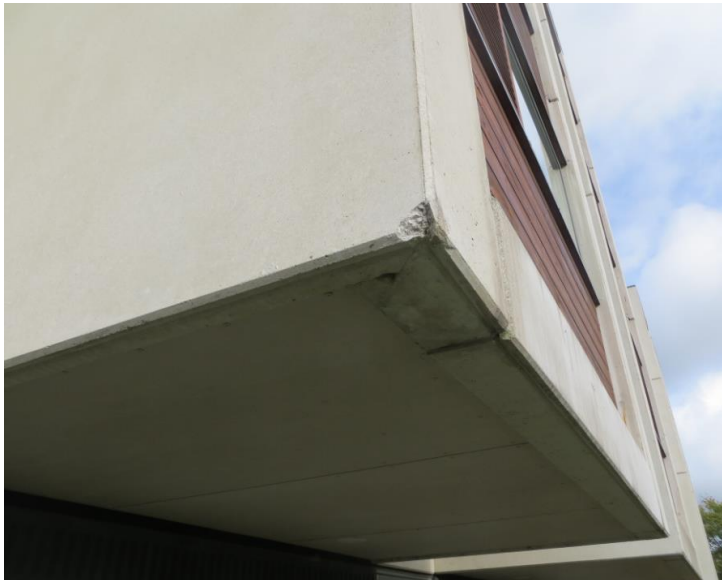
Figur 8: Afhugget hjørne på betonelement
