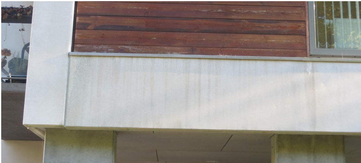
Figur 1: Begyndende nedbrydning af beton forårsaget af udvasket træbeskyttelse
