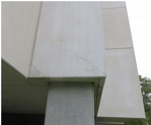
Figur 9: Revne i betonelement ved nr. 8.
