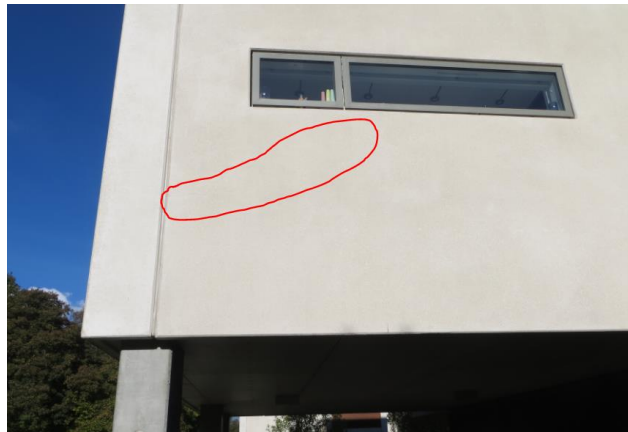
Figur 10: Revne i betonelement ved nr. 9.
