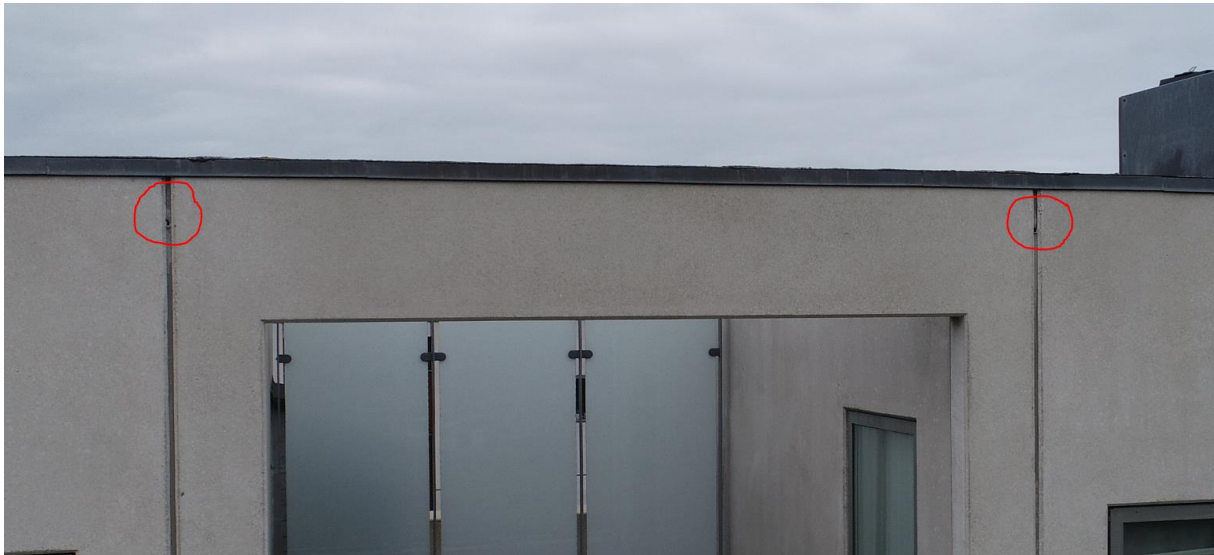
Figur 5: Huller i dilatationsfuger mellem elementsamlinger ved tag – efter montering af byggepladshegn under opførelsen af bebyggelsen.
