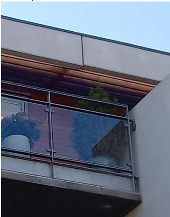
Figur 12: Løst betonelement - udhæng nr. 11.
