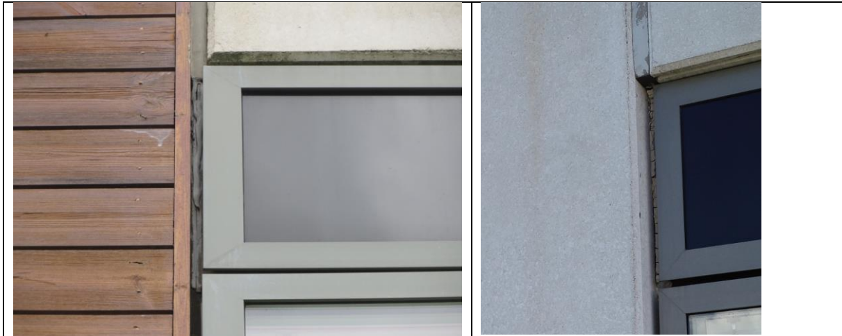
Figur 3: Forholdsvis bred fuge ved facadepartier, tilfælde ved sammenbygning mod træfacade og beton.
