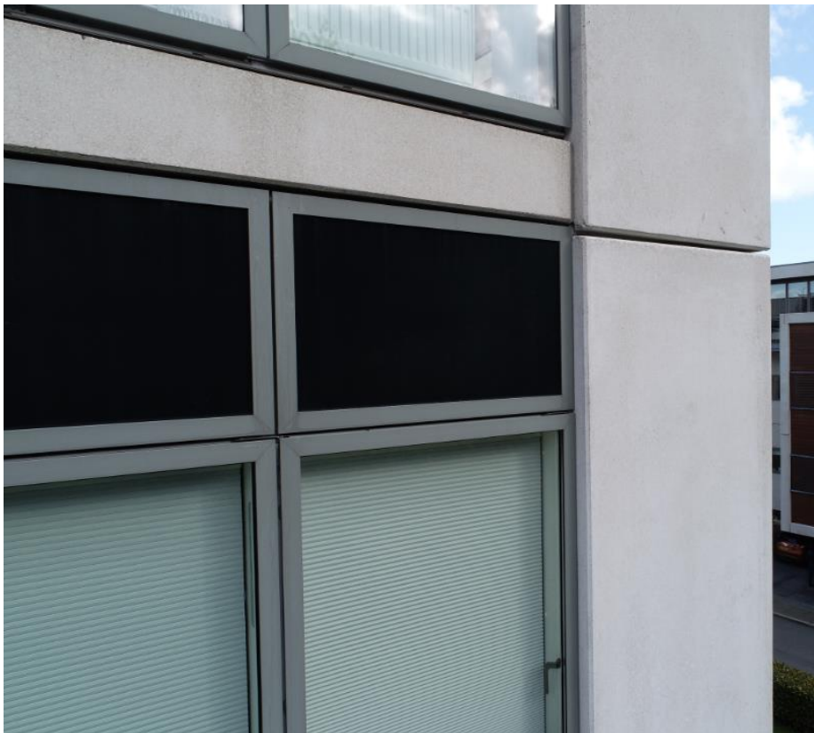
Figur 4: Facadeelement indbygget ved betonfacade.
